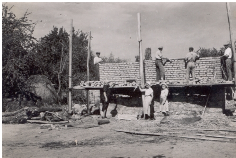
6. kép: Az istállópajta építése 1940-ben
